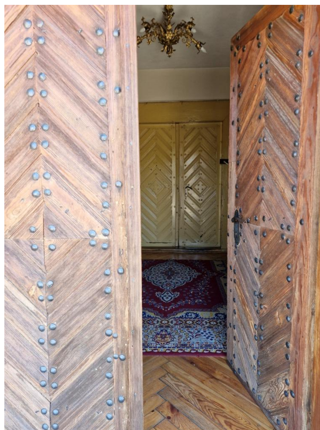
Widok na drzwi przeznaczone do renowacji od strony drzwi wejściowych.
