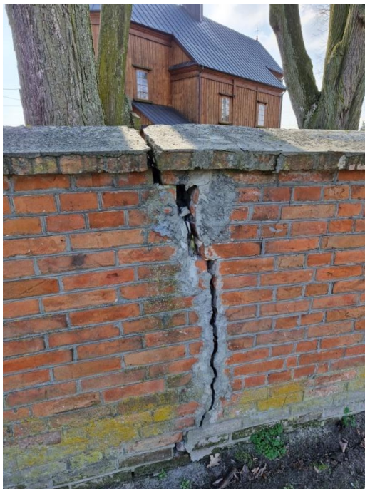
Widok od zewnętrznej części muru.
