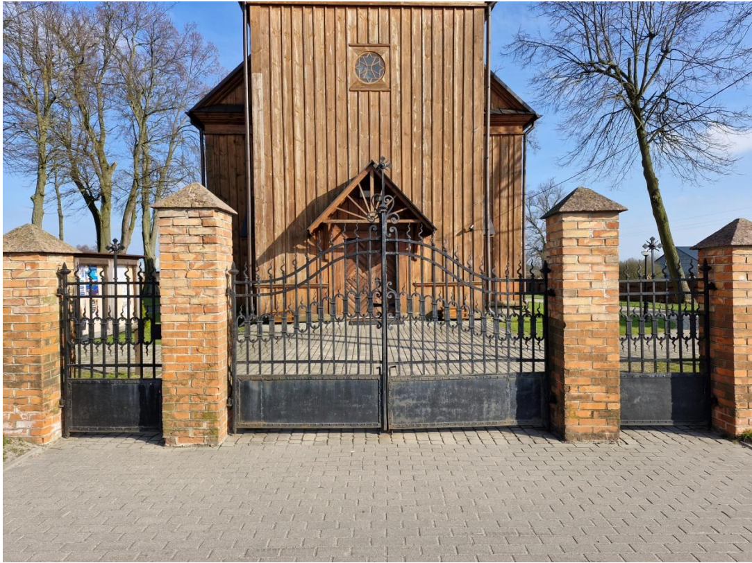
Brama wjazdowa wraz z furtkami (widok z ulicy).
