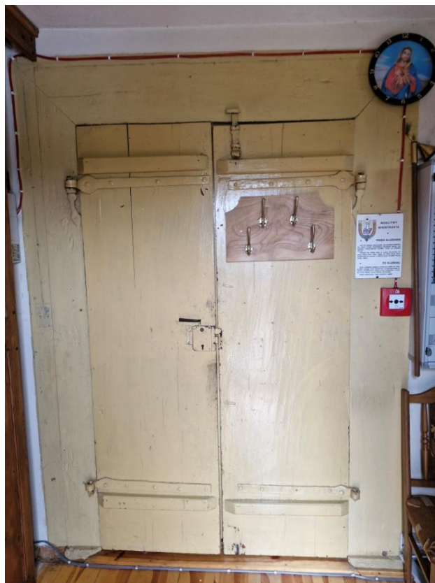
Drzwi dwuskrzydłowe pomiędzy prezbiterium, a zakrystią (widok od strony zakrystii). Wymiary skrzydeł: 2x 60x212 cm, szerokość futryny – 18 cm, grubość – 19 cm.
