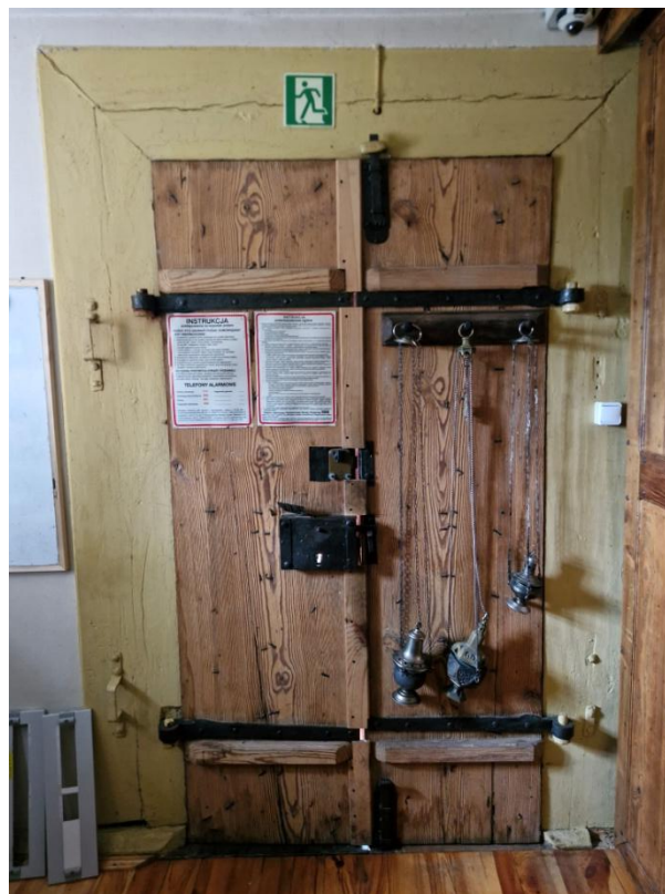
Widok futryny od strony wewnętrznej wejścia do zakrystii. Szerokość 32 cm.
