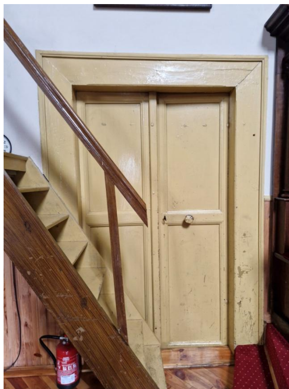
Drzwi dwuskrzydłowe pomiędzy prezbiterium, a skarbcem (widok od strony prezbiterium). Wymiary skrzydeł: 2x 60x218 cm, szerokość futryny – 18 cm, grubość – 19 cm.
