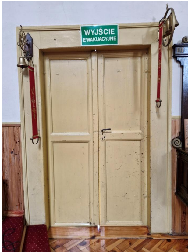
Drzwi dwuskrzydłowe pomiędzy prezbiterium, a zakrystią (widok od strony prezbiterium). Wymiary skrzydeł: 2x 60x212 cm, szerokość futryny – 18 cm, grubość – 19 cm.
