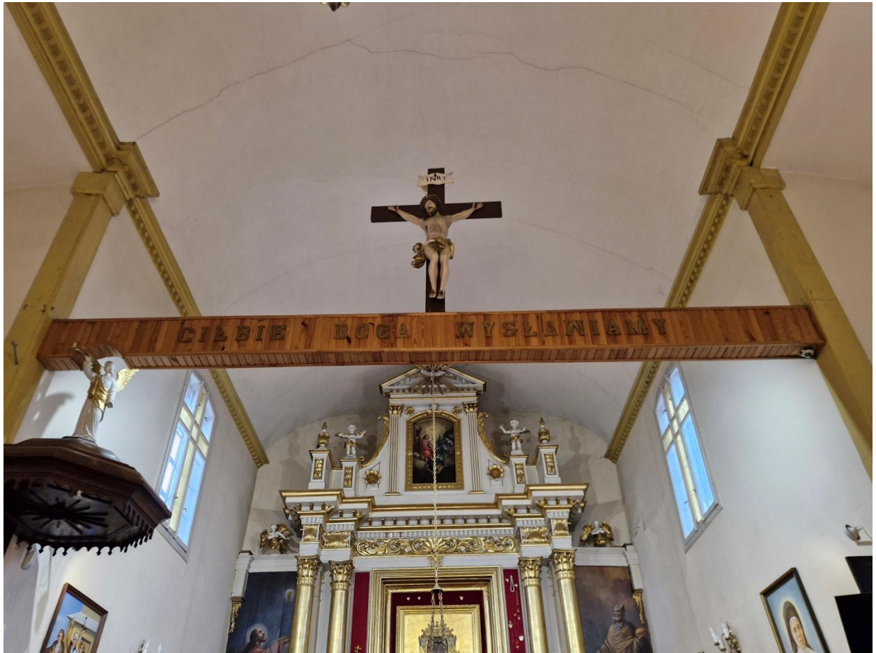
Belka nad prezbiterium pokryta boazerią (widok z nawy głównej). Wymiary: 25x35 cm, długość – 616 cm, wysokość zawieszenia – 483 cm.
